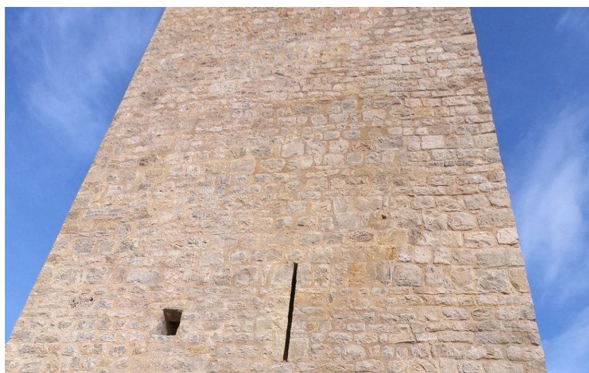
Vue du bas de la tour du Défens (Département du Var)
